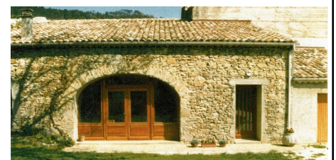
1986-1988 : Construction par l'entreprise DERRIEN avec la participation active de Marc PINET
